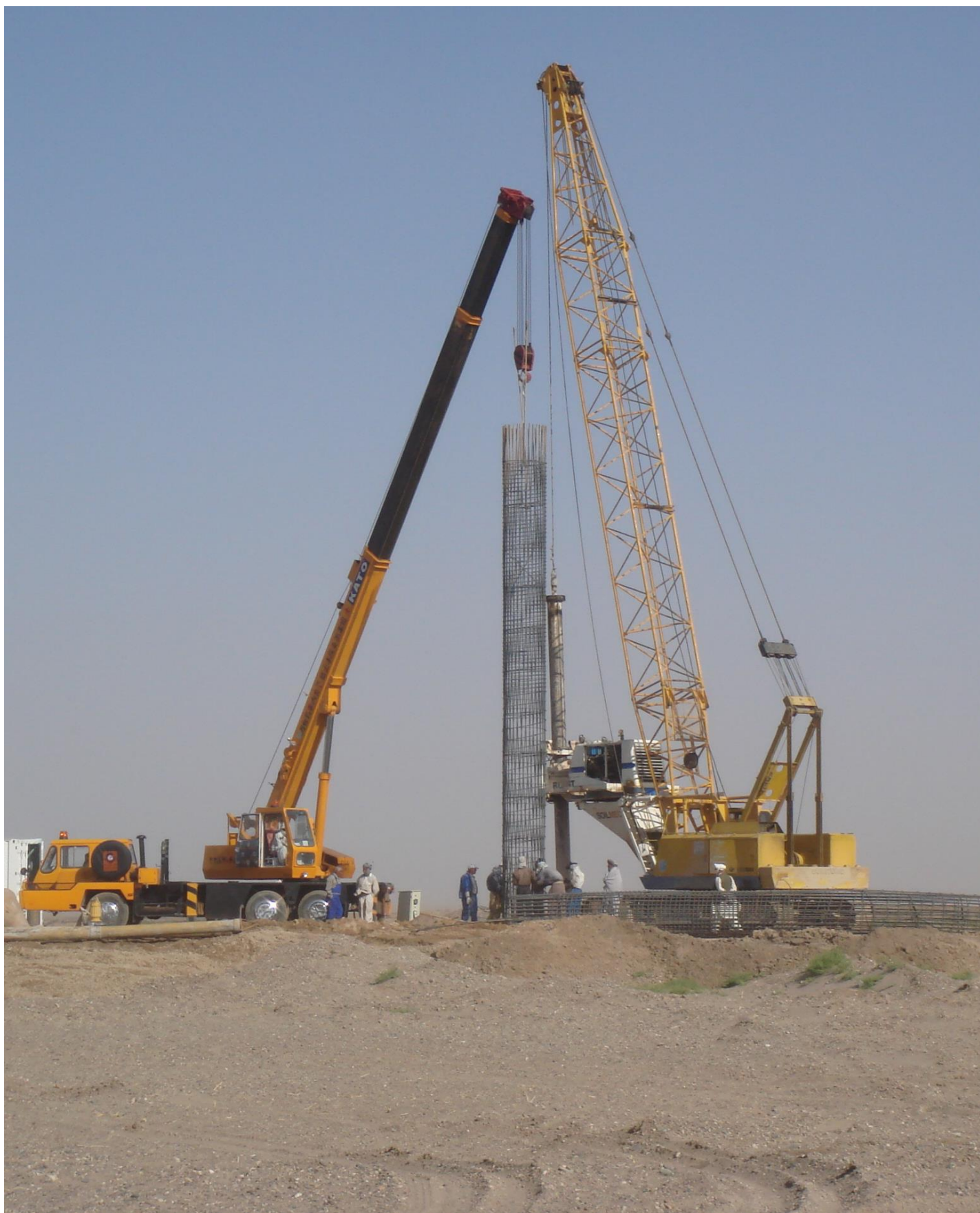
نصب قفس آرماتور
