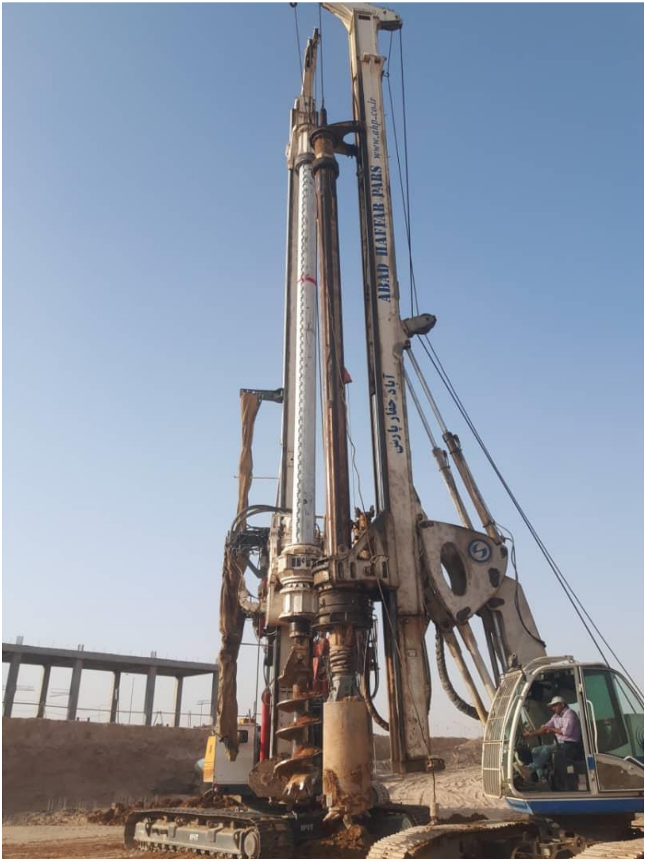
اجرای شمع های پروژه اسکله پتروشیمی پارس جنوبی عسلویه
