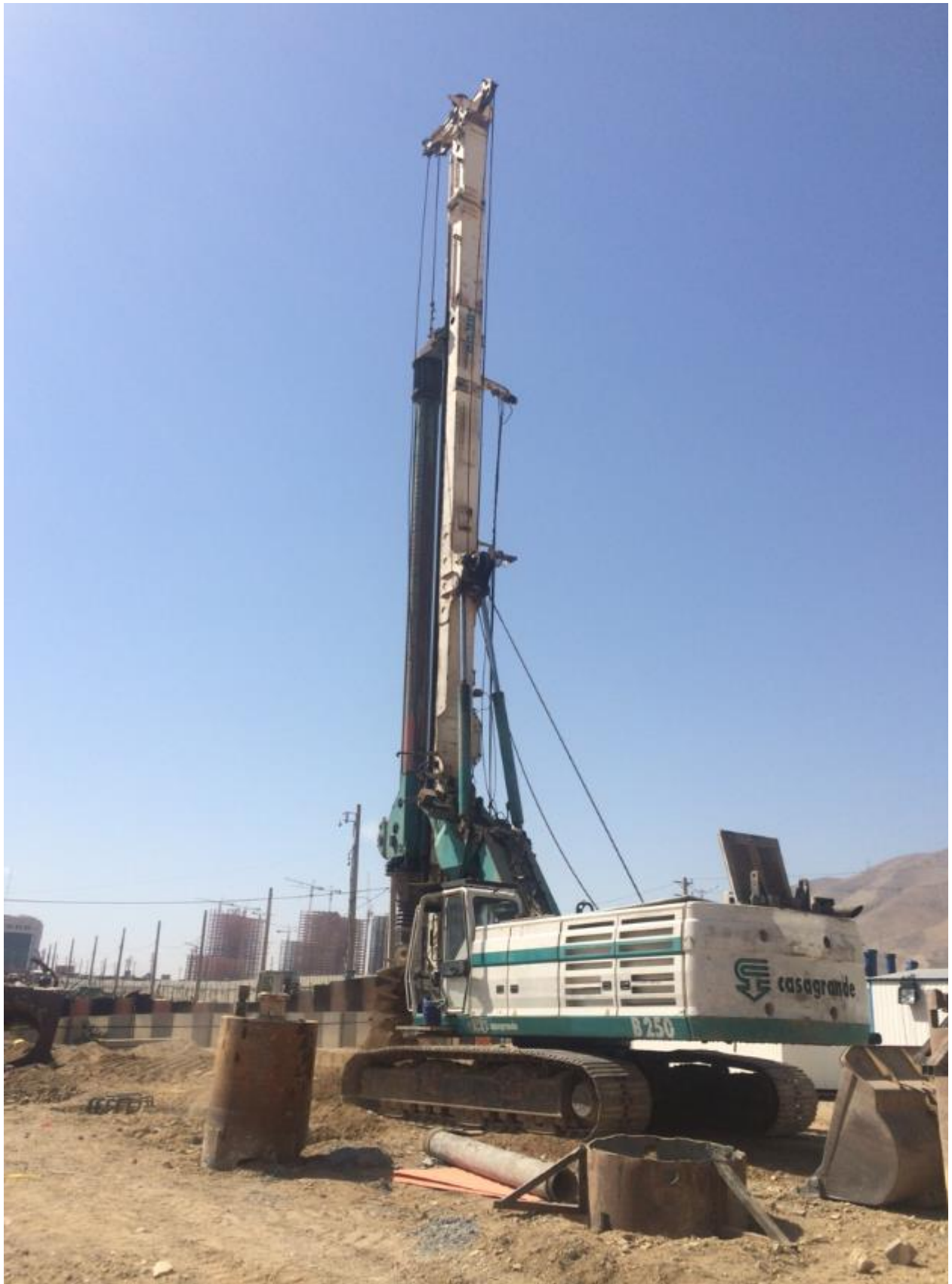
اجرای شمع های پروژه تقاطع غیر همسطح و زیرگذر ایران مال
