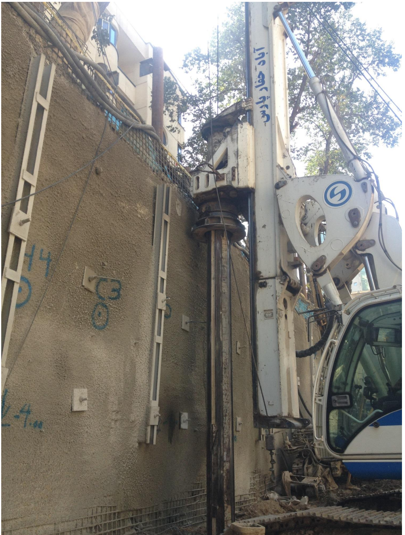
اجرای شمع های پایدار سازی گود (دیوار برلینی) پروژه تجاری - اداری خیابان فرشته تهران
