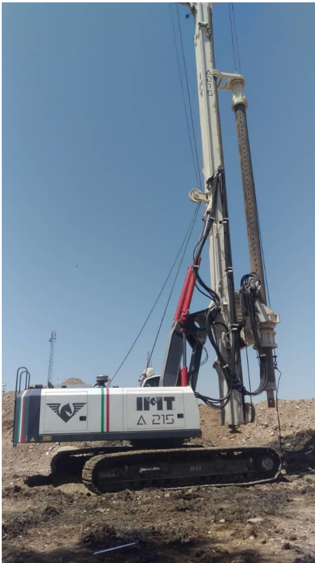
اجرای شمع های پروژه دیوار حائل پلدختر
