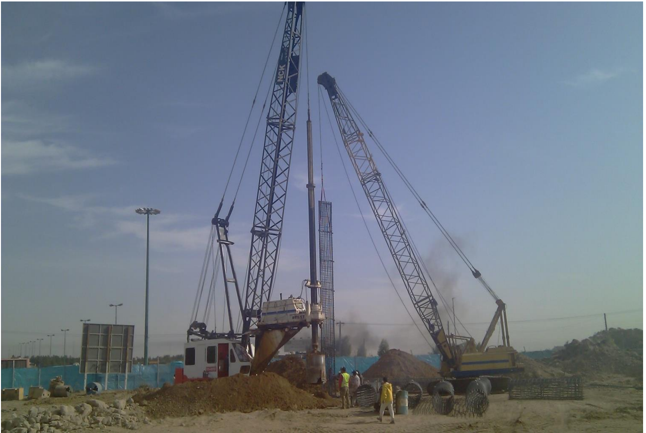
اجرای شمع های تقاطع غیر همسطح میدان ۷۲ تن قم
