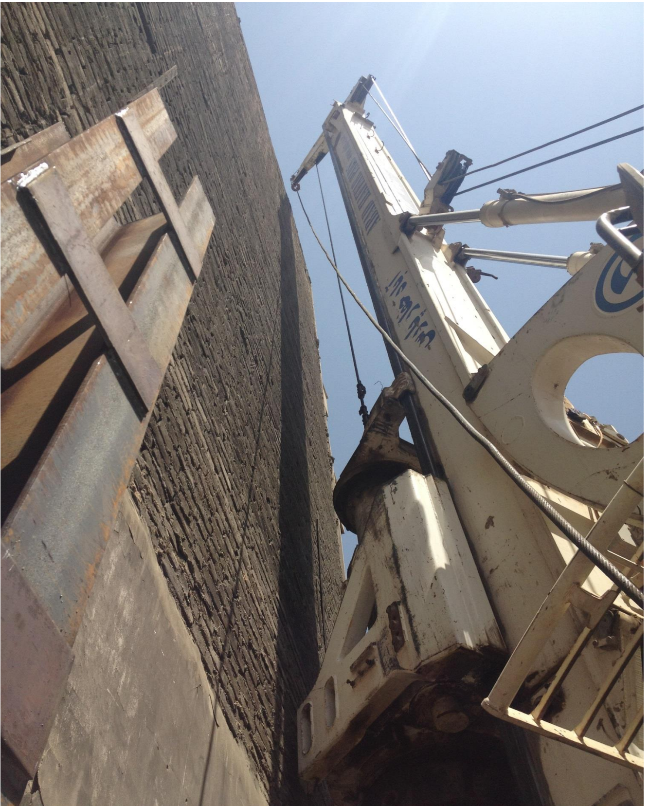
اجرای شمع های پایدار سازی گود (دیوار برلینی) پروژه بانک سینا - خیابان آزادی تهران
