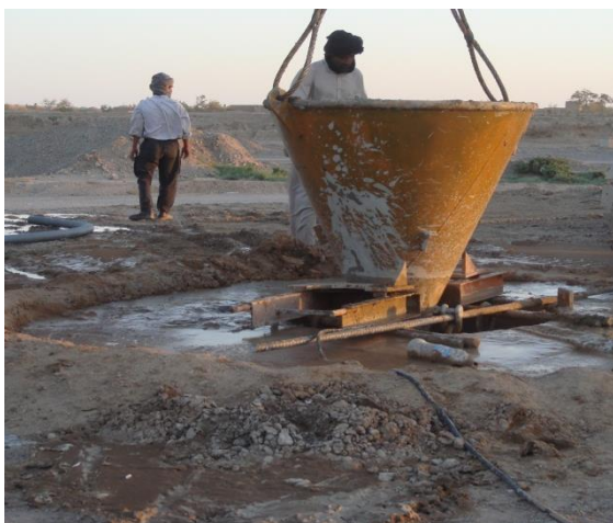
نصب قیف و لوله های ترمی به منظور بتن ریزی
