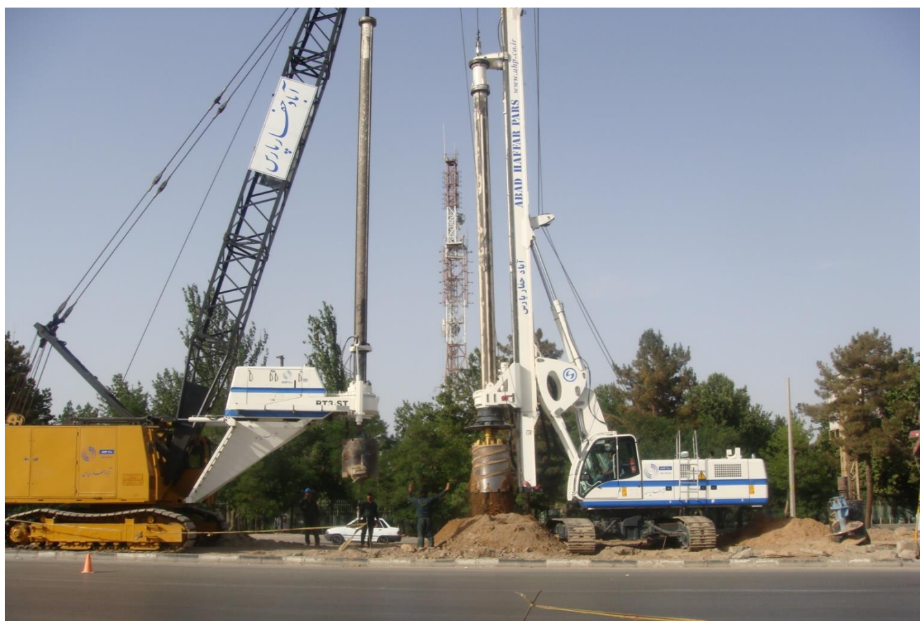
اجرای شمع های پل کمربندی مشهد
