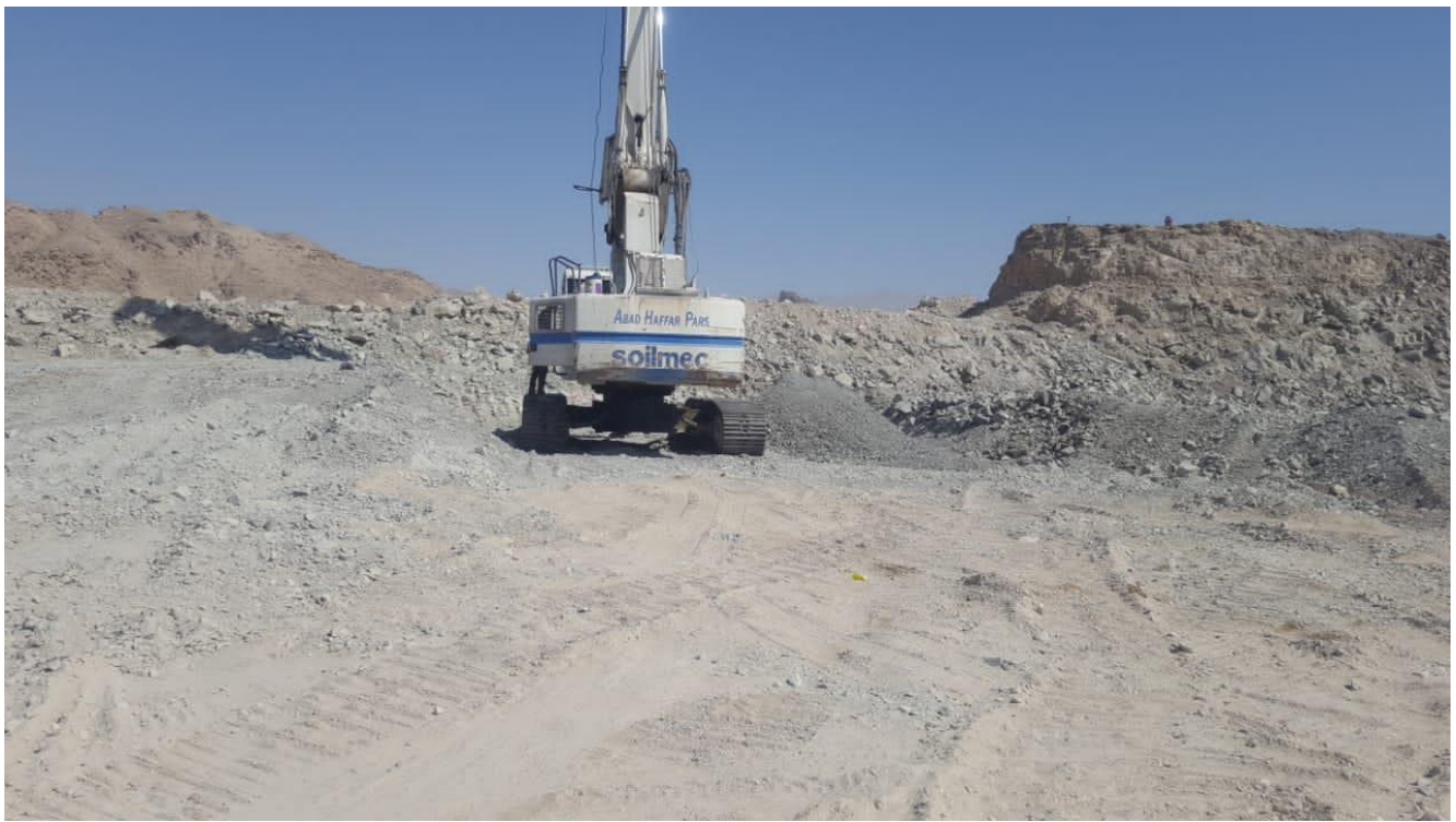
اجرای شمع های پروژه پل راه آهن تبریز مرند
