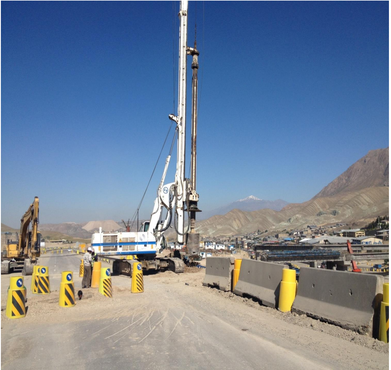
اجرای شمع های پل رو گذر- پروژه پردیس
