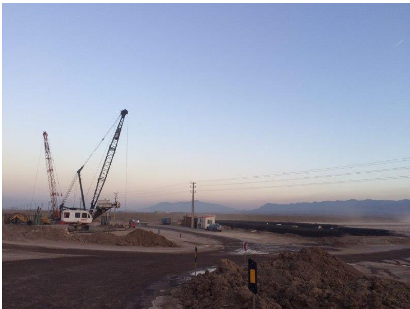
اجرای شمع های پروژه کنار گذر جنوبی تهران - اشتهارد
