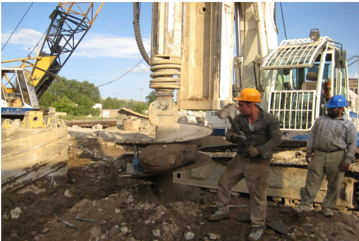
اجرای شمع های پل بزرگ باسمنج - تبریز
