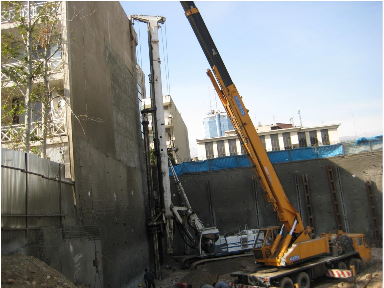
اجرای شمع های پایدار سازی گود (دیوار برلینی) پروژه تقاطع خیابان جردن - ستاری
