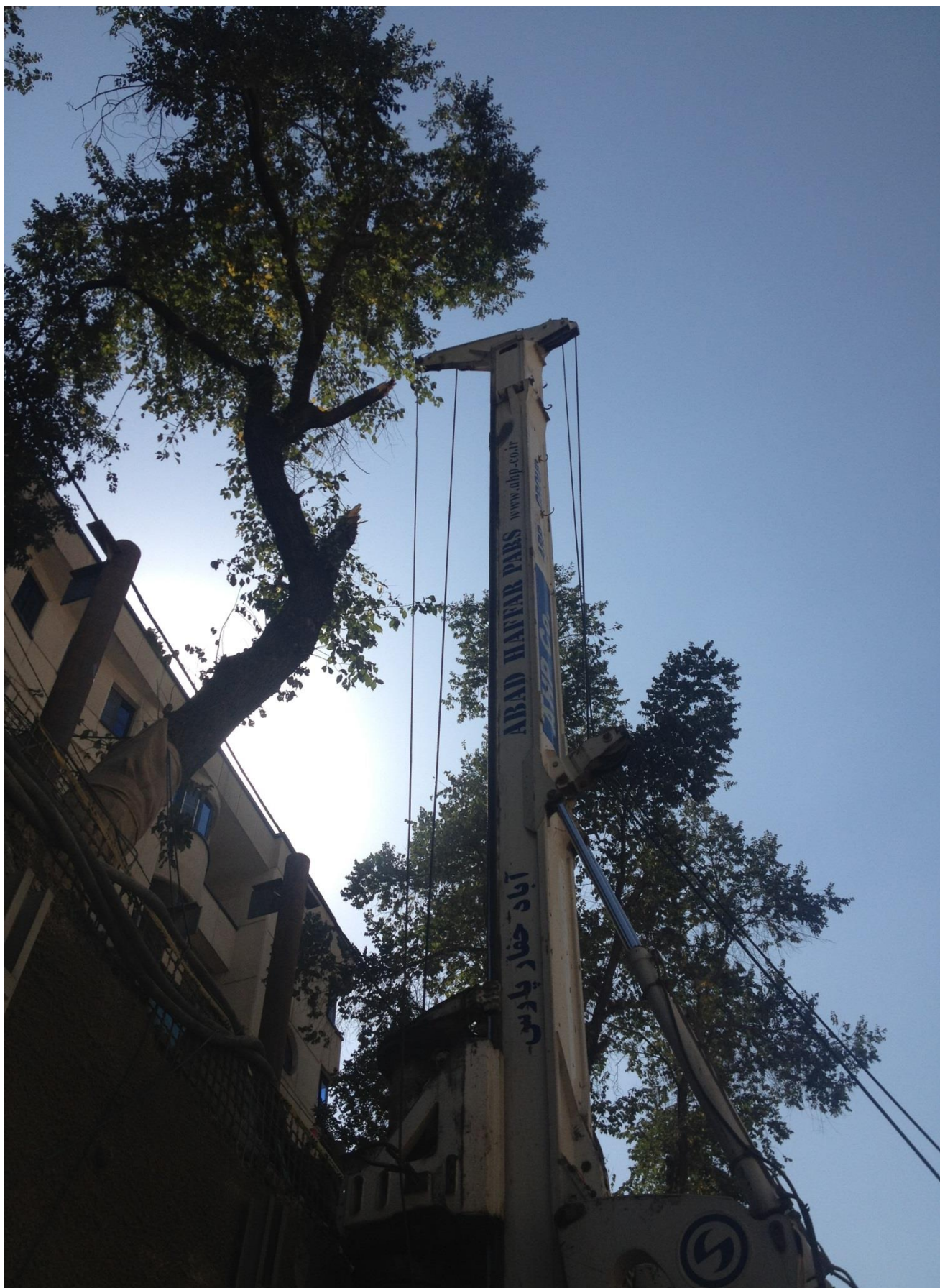
اجرای شمع های پایدار سازی گود(دیوار برلینی) پروژه تجاری -اداری خیابان نیلوفر تهران
