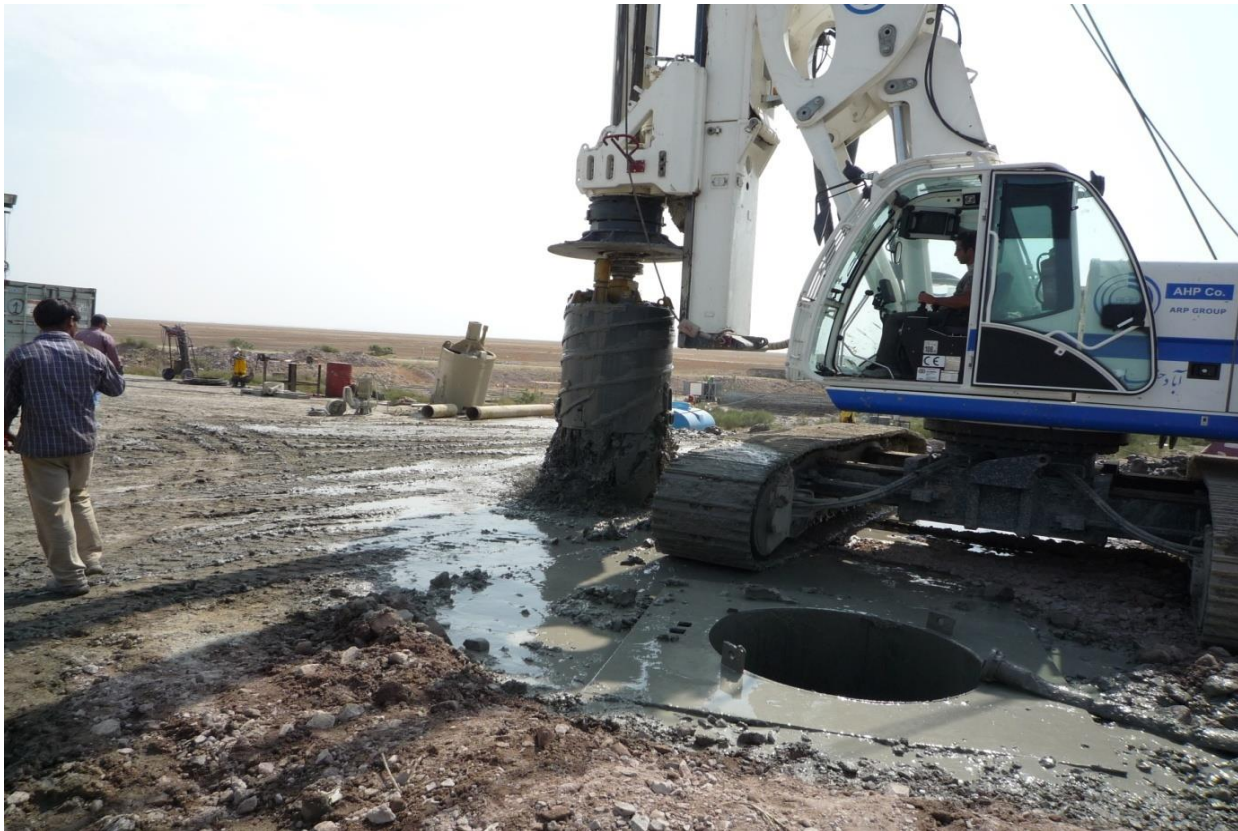
اجرای شمع های پل تقاطع سلماس و شورکند در محور ارومیه - تبریز
