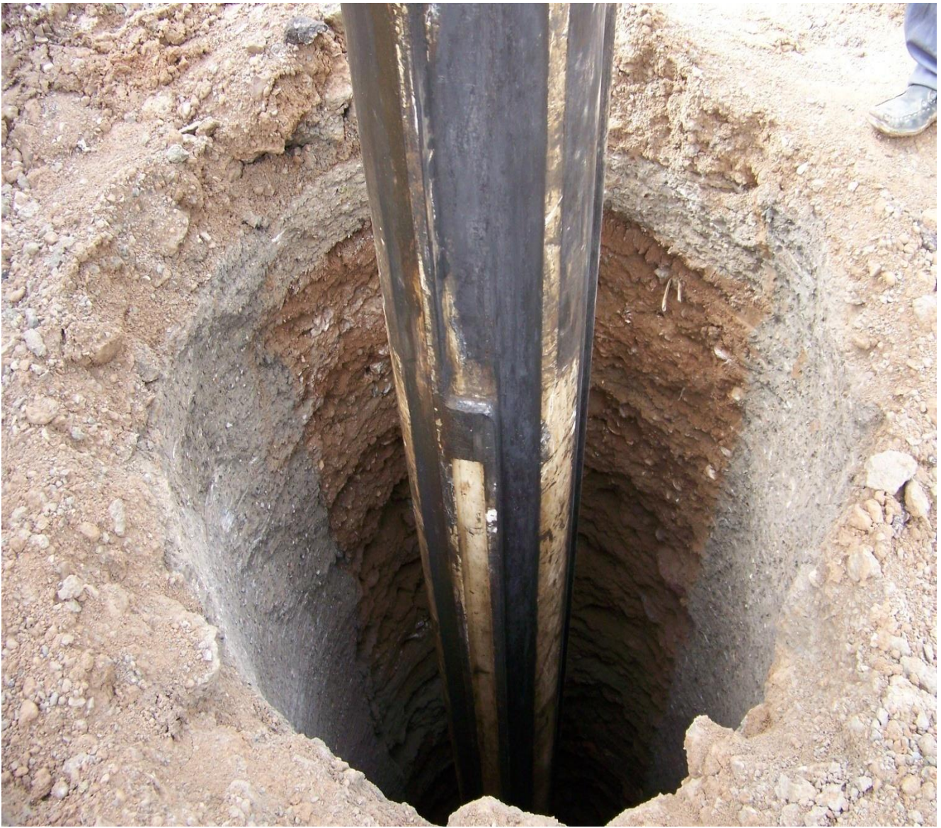
اجرای شمع های سکانت-مترو تبریز
