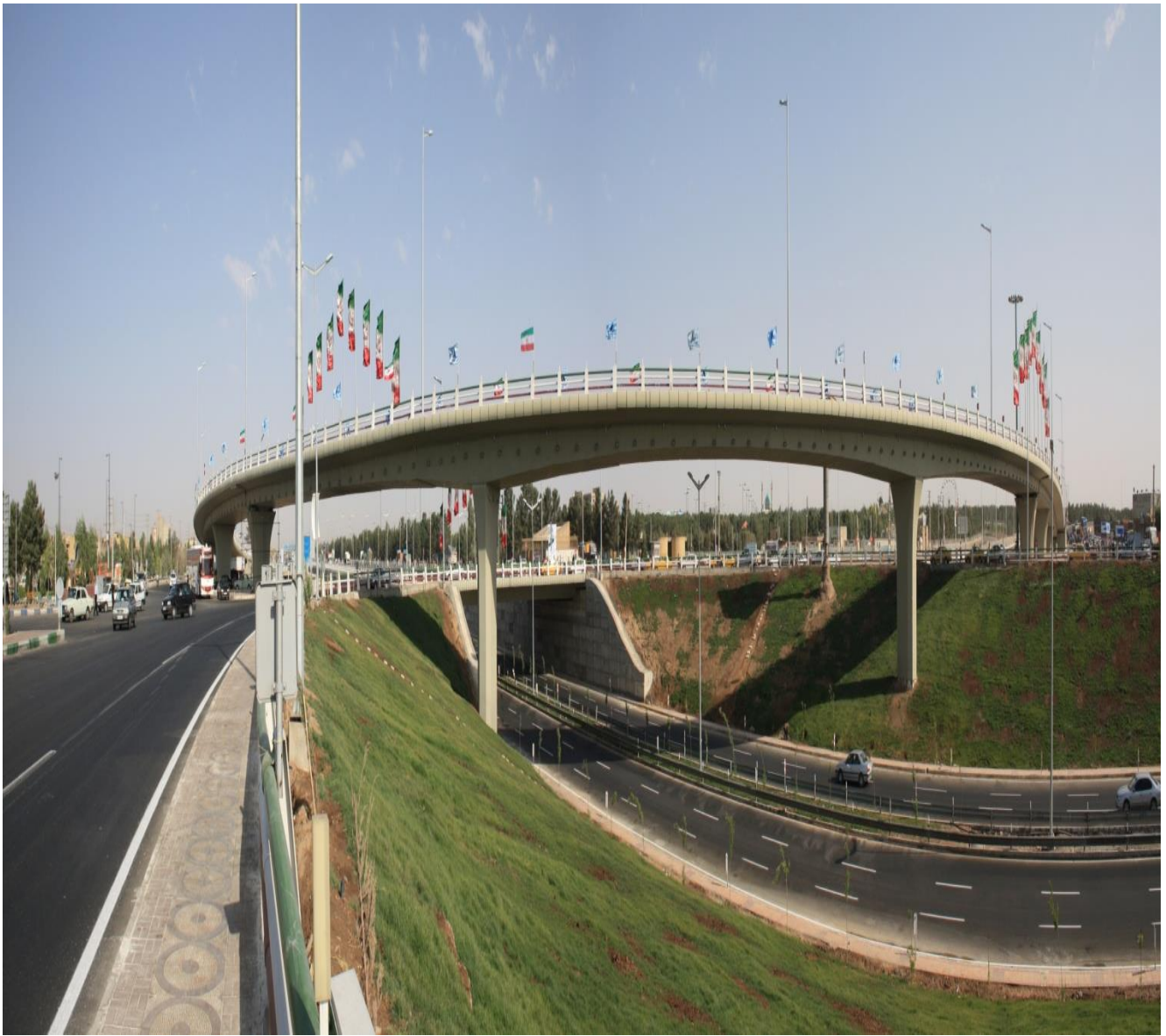
اجرای عملیات شمع های میدان بزرگ ۷۲ تن شهر قم
