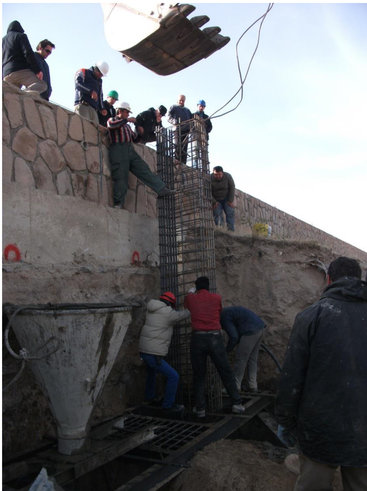
ایستگاه دپوی لاله مترو- تبریز هنگام بتن ریزی
