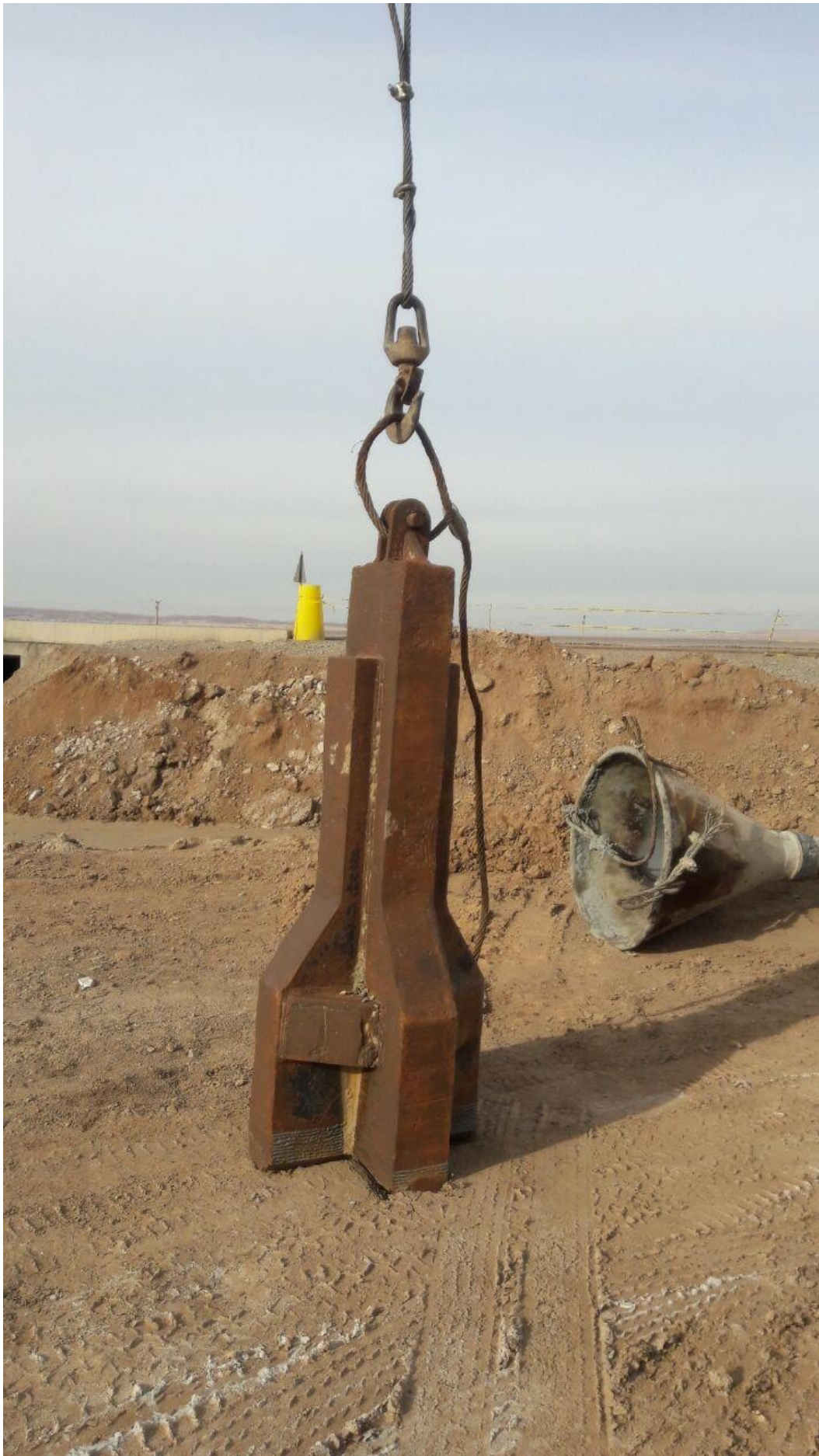
حفاری به وسیله ترپان در لایه بسیار سخت سنگی
